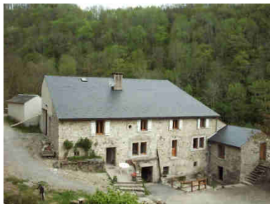
La face sud du Moulin, 2001
